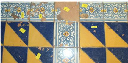
Die vorhandenen Fliesen hatten starke Abnutzungspuren und waren an vielen Stellen beschädigt. Bei der Sanierung des Westflügels wurden in einigen Räumen, unter den Vorgaben des Denkmalschutzes, einzelne Bodenfliesen auf Basis der alten Muster neu gefertigt.
