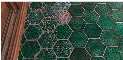
Die vorhandenen Fliesen hatten starke Abnutzungspuren und waren an vielen Stellen beschädigt. Bei der Sanierung des Westflügels wurden in einigen Räumen, unter den Vorgaben des Denkmalschutzes, die vorhandenen Bodenfliesen auf Basis der alten Muster neu gefertigt und verlegt.
