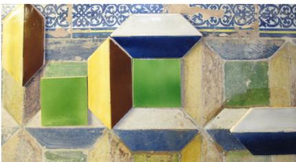
Die vorhandenen Fliesen hatten starke Abnutzungspuren und waren an vielen Stellen beschädigt. Bei der Sanierung des Westflügels wurden in einigen Räumen, unter den Vorgaben des Denkmalschutzes, die vorhandenen Bodenfliesen auf Basis der alten Muster neu gefertigt und verlegt.
